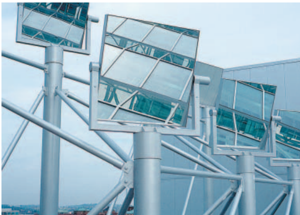
SOLSPEIL. Lyset inne i bygningen reguleres av såkalte heliostater. Store solspeil på taket fanger opp mest mulig sollys i løpet dagen, noe som er spesielt viktig om vinteren.
